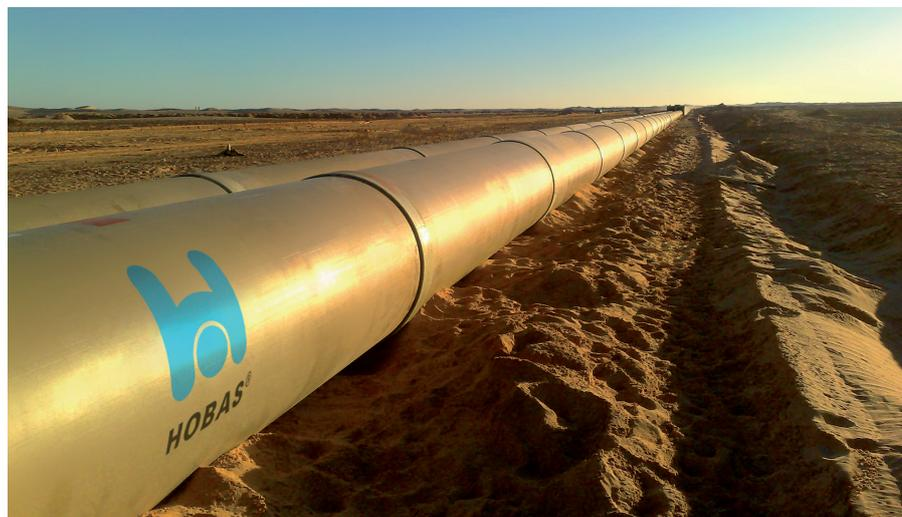
**Bild 2.** An zahlreichen Standorten rund um den Erdball werden Rohrleitungen aller Größen von 150 mm bis 3600 mm Durchmesser produziert, ebenso verwandte Systeme wie Schächte und Sandfänger.
